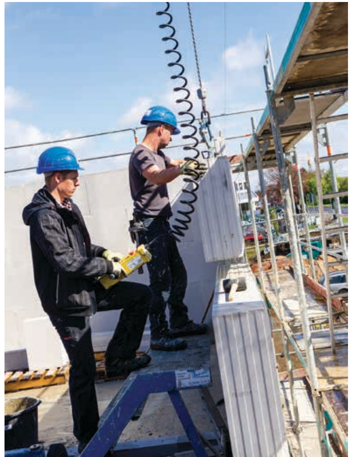
Mit einem Hub entsteht bis zu 0,65 m 2 maß- und passgenaues KS-Plus Mauerwerk.
