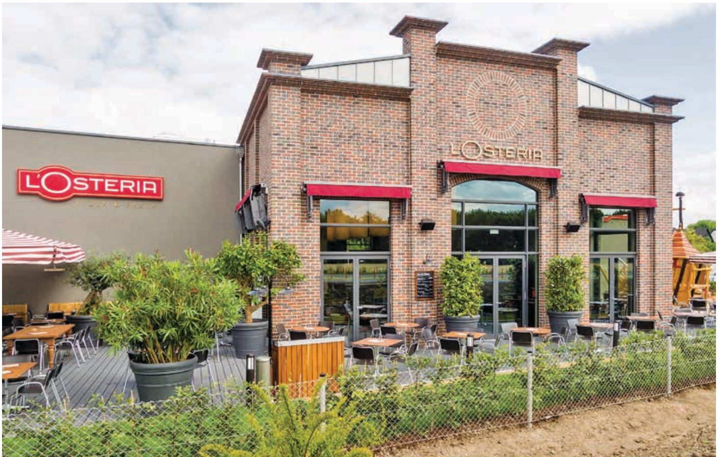
Die L'Osteria in Hürth wurde in einer Bauzeit von nur 18 Wochen errichtet.
