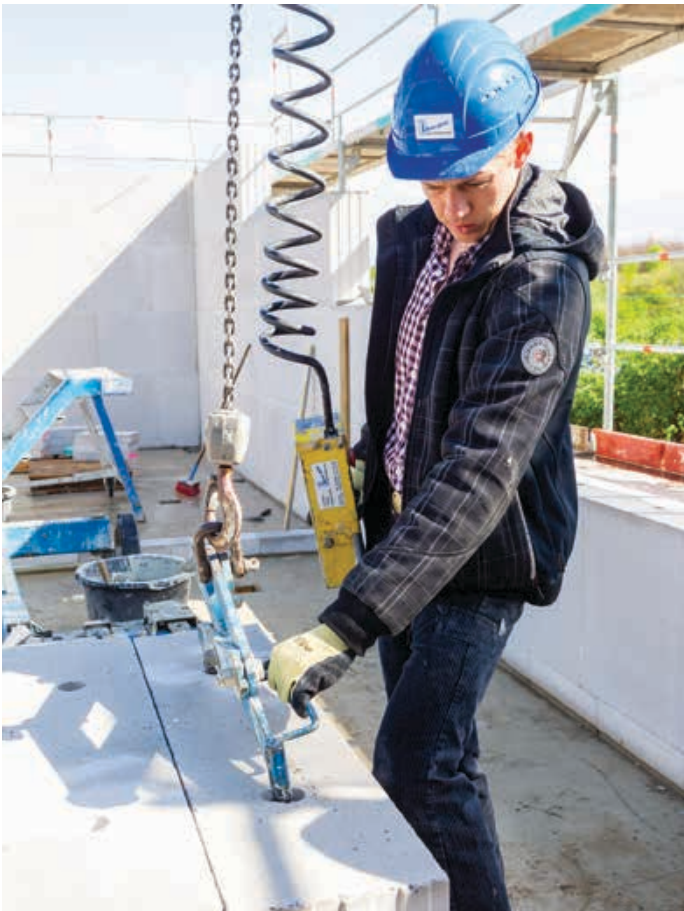
Die Planelemente werden mit einem Versetzgerät verarbeitet. | Fotos: KS-Plus
